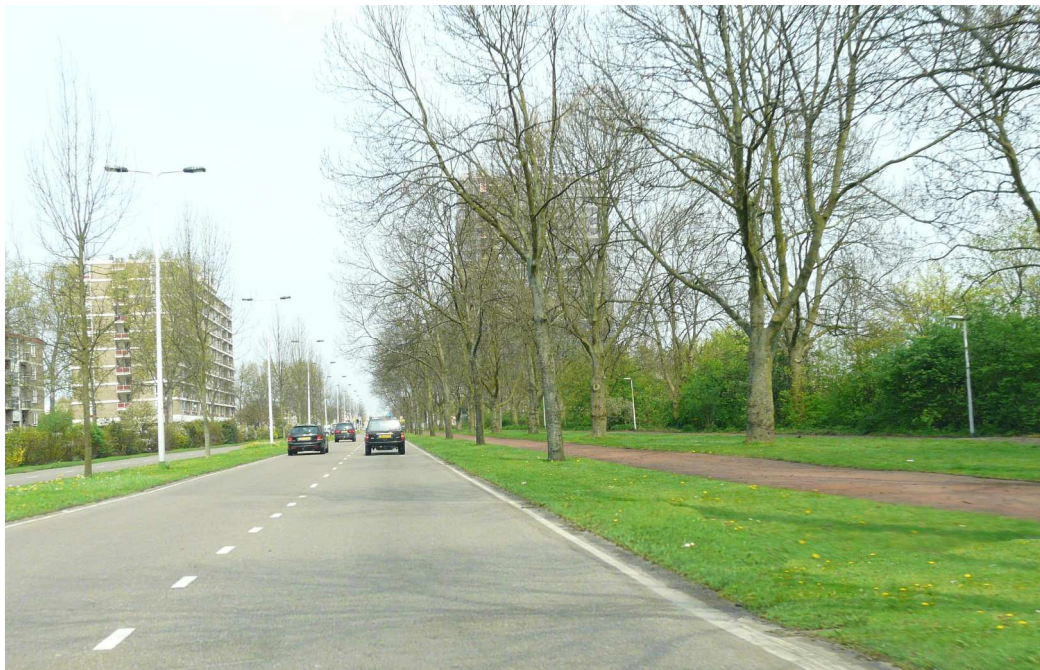
Figuur 5.1 : Foto van huidige situatie Churchillaan
