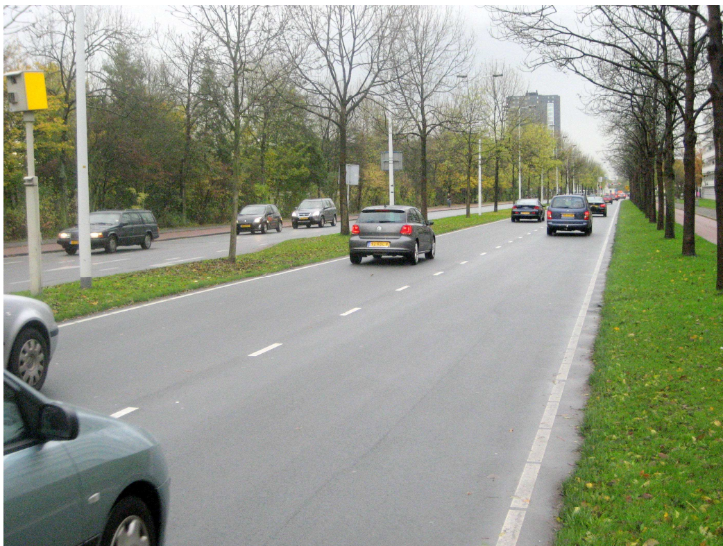
Figuur 5.3 : Foto van huidige situatie Churchillaan
