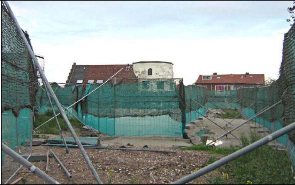
Figuur 3.10 Hekwerk waarmee vliegroutes van watervleermuis en gewone dwergvleermuis behouden blijft (Koelman, 2008)
