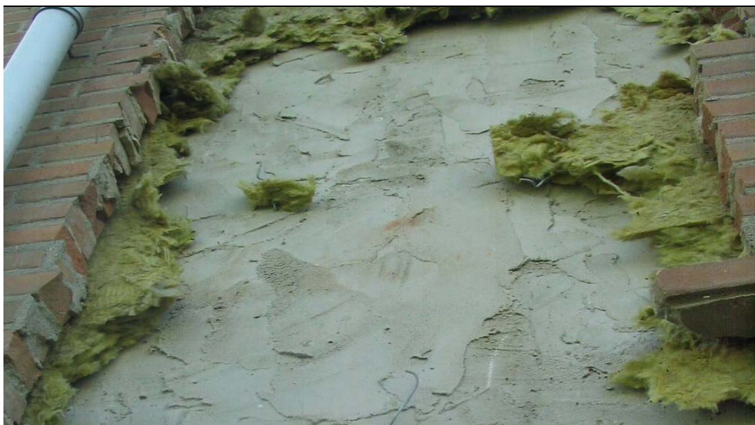
Figuur 3.18 Blootgelegde spouwmuur waar ook het isolatiemateriaal is verwijderd
