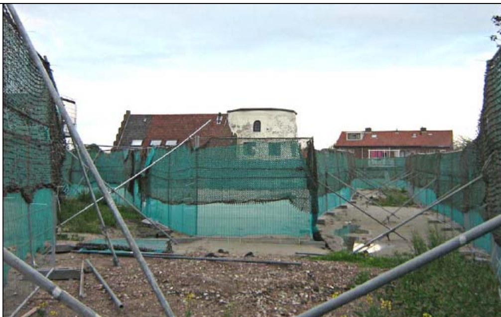
Figuur 3.11 Hekwerk waarmee vliegroutes van watervleermuis en gewone dwergvleermuis behouden blijft (Koelman, 2008)
