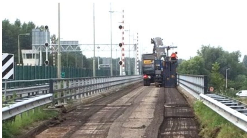
Een asfaltfrees verwijdert het wegdek op de busbrug.
