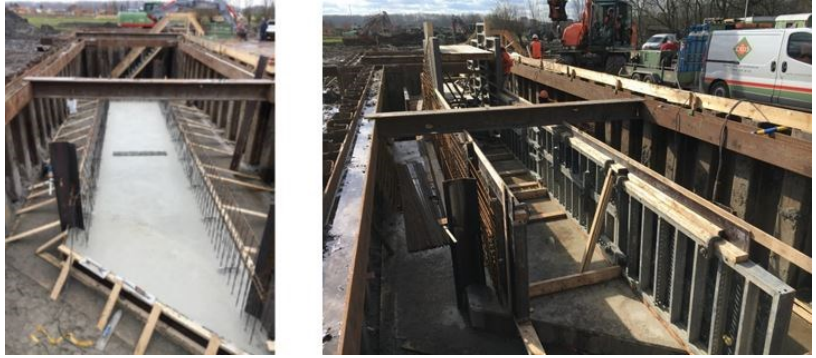
Bouwkuip en fundering poldergemaal
